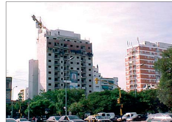
Foto: DGEyC. Edificio en construcción, Bdo. de Irigoyen e Independencia
